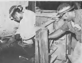
RIGGERNAN TA usa un chain block pa move un pida staal di tres ton for di e fundeshi di Combination Unit No. 5, robes. Un buraco ta worde corá, centro, pa yuda den ponemento di e chain block. Nasario Tromp, Foreman di Metal Trades, dreci, ta inspepta e progreso.
